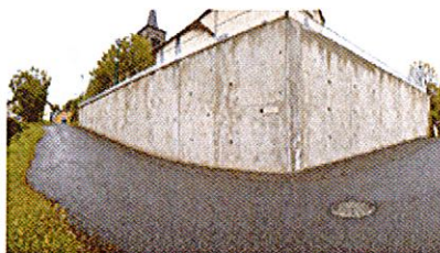
Saint-Bonnet-près-Orcival Réfection du mur de soutènement du parvis de l'église
