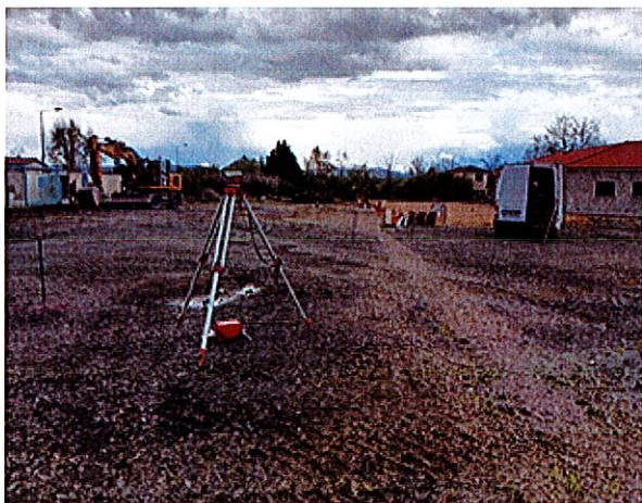
Pendant les travaux
