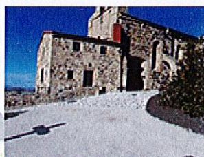
Montmorin : Travaux parvis de l'église
