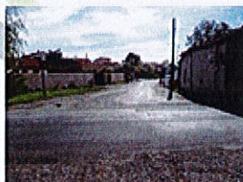
Aubiat : Diagnostic voirie avant travaux
