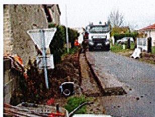
Saint-Clément- de-Régnat : Travaux de voirie communale
